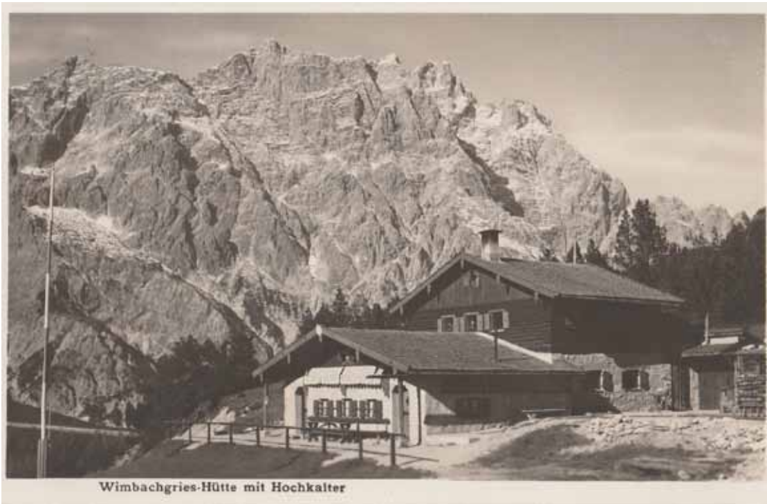
Ansicht Wimbachgrieshütte mit dem Hochkalter um 1926.
